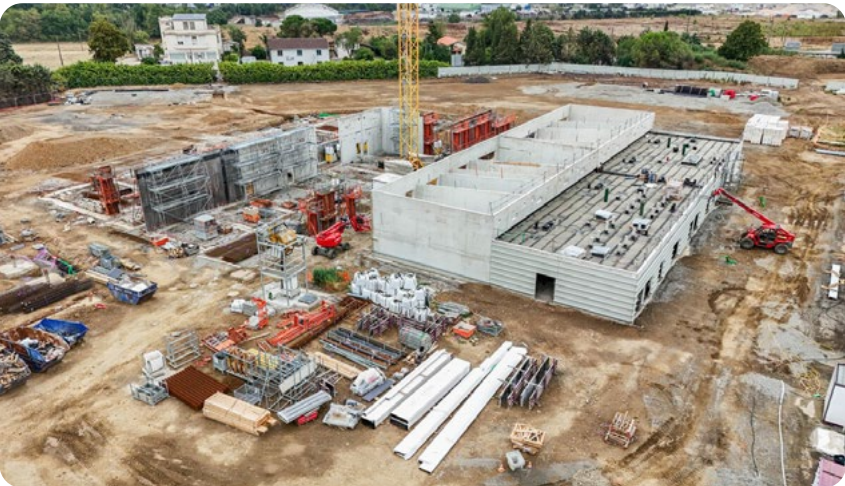
Photo de chantier du futur Technocampus Hydrogène Occitanie. Léo Arcangeli (Région Occitanie)
